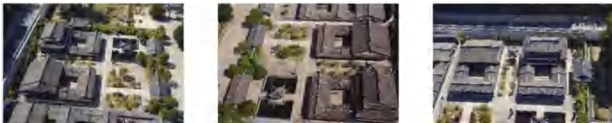
(a) 无人机右视拍摄影像
